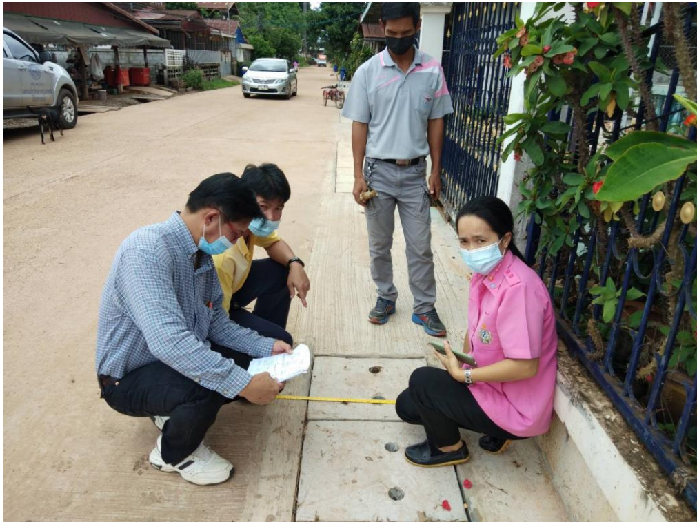
โครงการก่อสร้างรางระบายน้ำ คสล. บ้านท่าบ่อ หมู่ที่ 6
