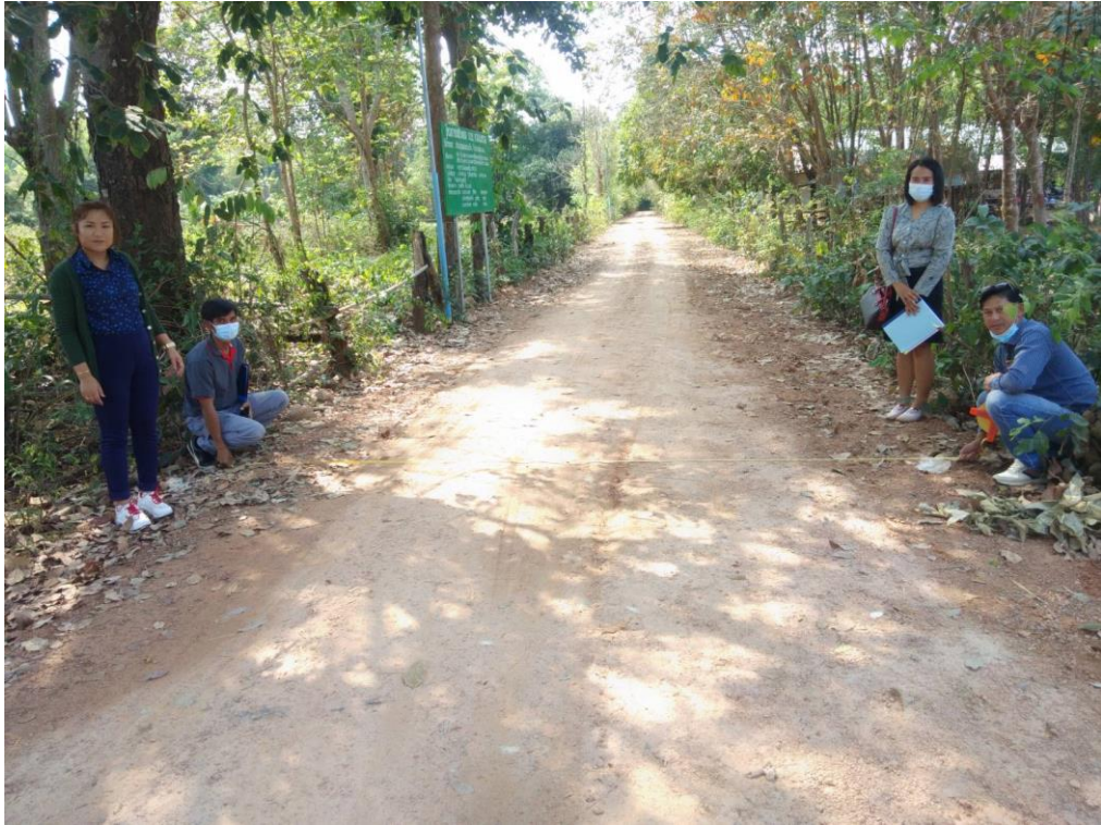
โครงการปรับปรุงซ่อมแซมถนนดิน บ้านดอนสมอ หมู่ที่ 1
